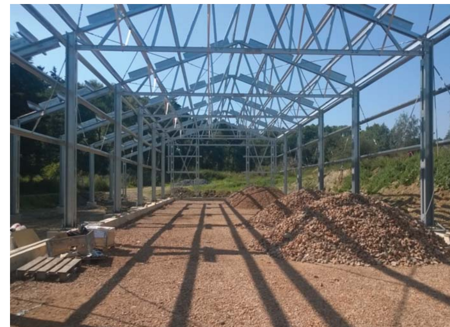
Průběh montáže ocelové konstrukce haly a zarovnávání prostoru podlahy.
