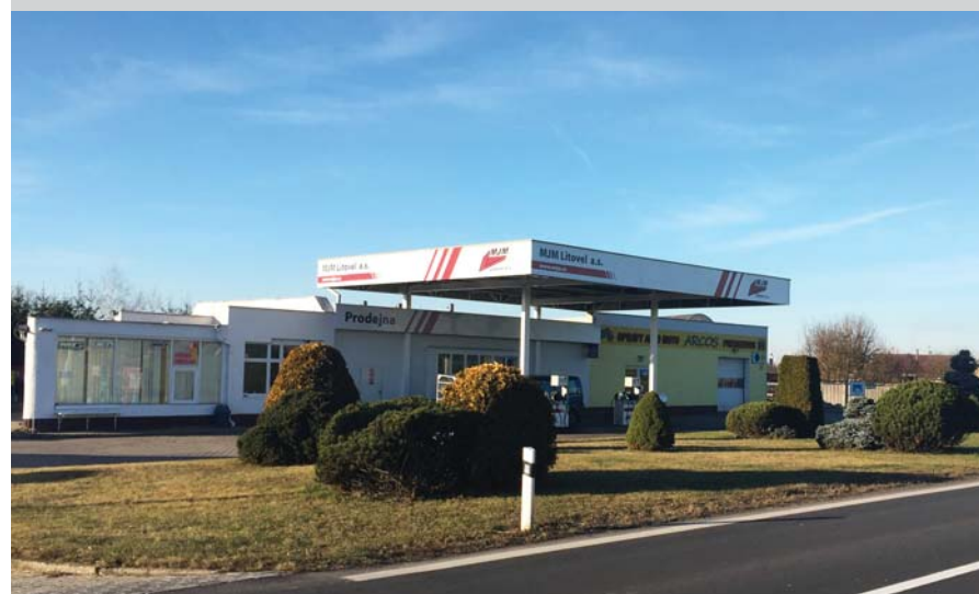
Čerpací stanice v Újezdě – Rybníčku
