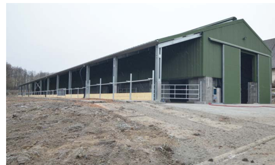
Pohled na dokončenou halu z jižní strany.
